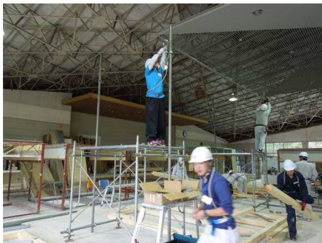
図3-9 木造軸組工法の建て方実習における足場組立
