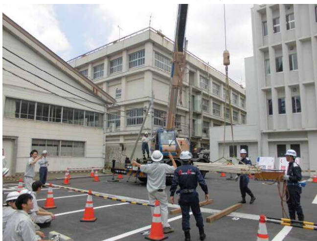
図 3-6 クレーン運転体験実習
