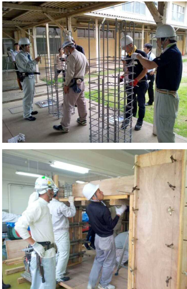
図 3-10 現場実務施工体験実習（上：鉄筋組立、下：型枠施工）
