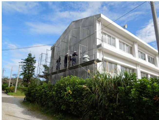
図3-13 躯体系技能者の足場実習
